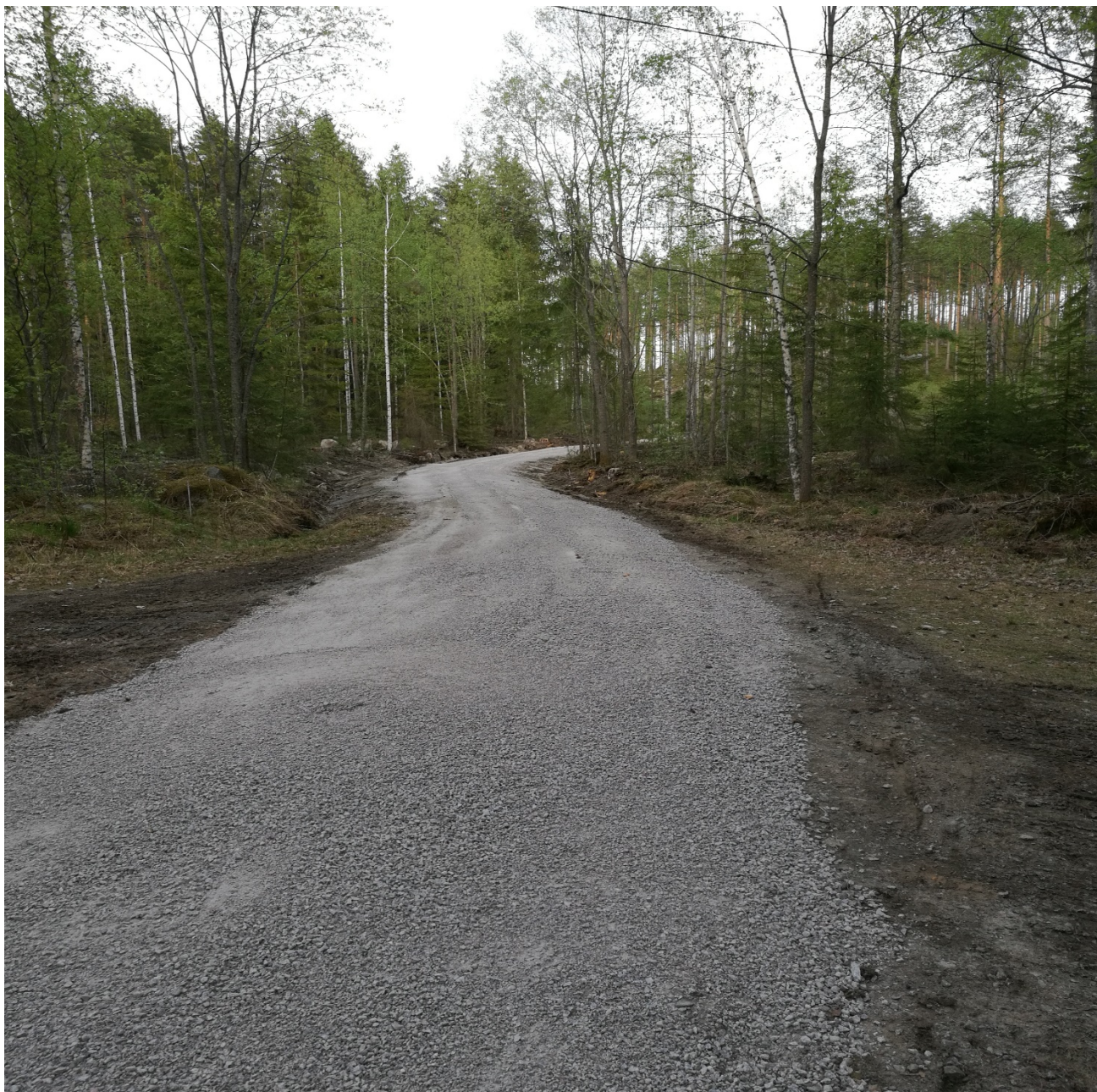
Kuva. Mukuran kunnostettu tie
